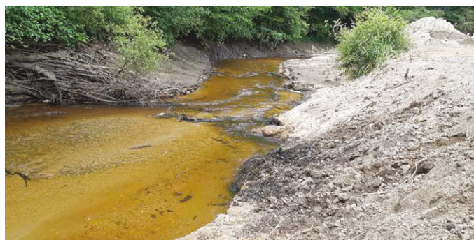
↑ Forges du buisson après les travaux
