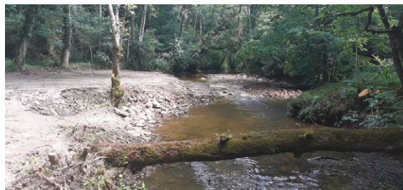
↑ Forges du buisson après les travaux
