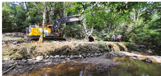
↑ Forges du buisson après les travaux
