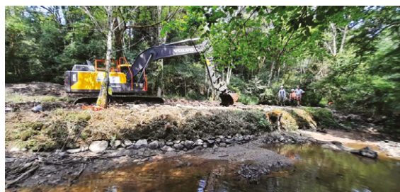
↑ Forges du buisson après les travaux
