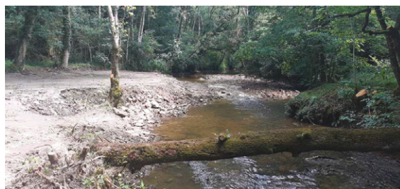
↑ Forges du buisson après les travaux
