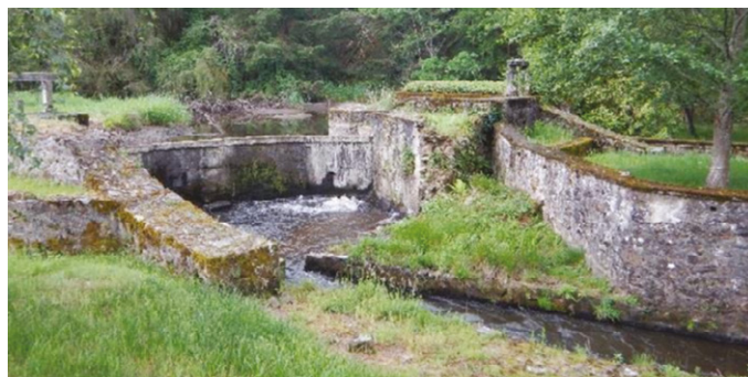
↑ Forges du buisson avant les travaux
