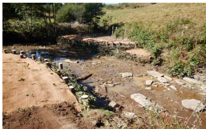
↑ Assèchement temporaire du lit de la rivière et pose de géotextile sur les berges
