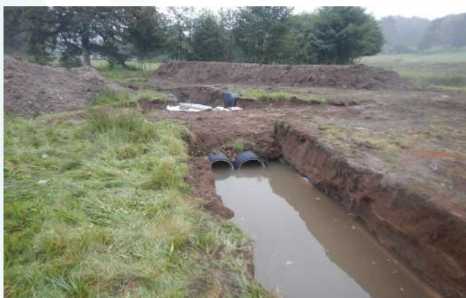
↑ Déviation temporaire de la rivière par deux canalisations
