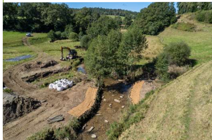
↑ Photographies avant et après l'enrasement du seuil du pont de Rhodes
