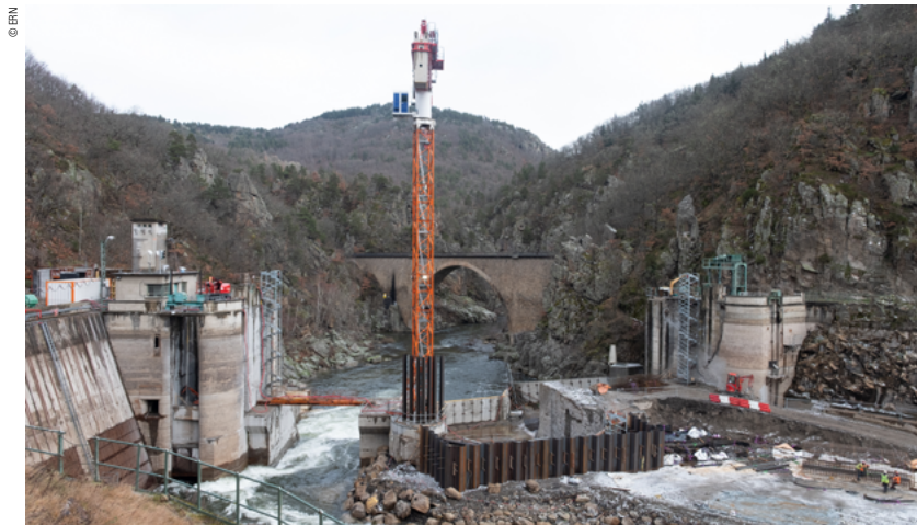
← New Poutès construction site
