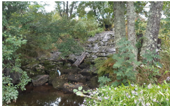
↑ Site du Moulin du Pont avant travaux, le 22/09/2025
