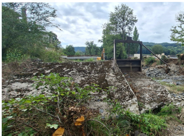
↓ Relique du seuil de la Darne avant travaux
