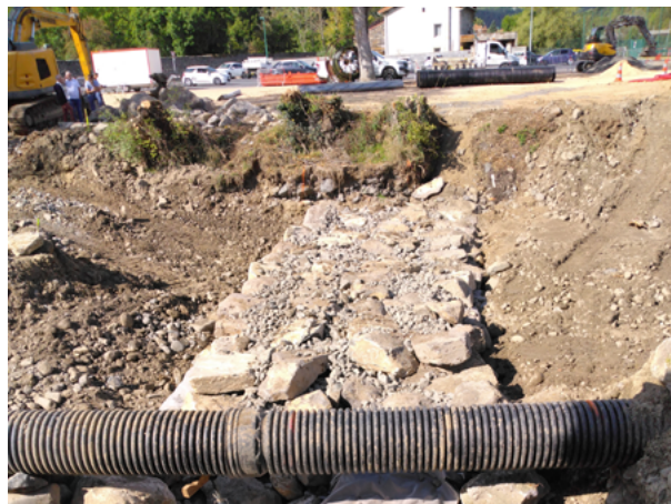
↓ Seuil de fond, stabilisation du fond du lit
