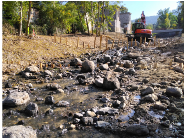
↓ Pieux en bois enfoncés de 60 à 80cm, stabilisation du fond du lit
