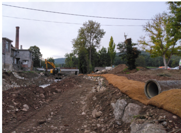
↓ Reprofilage et renforcement des berges, pose du géotextile
