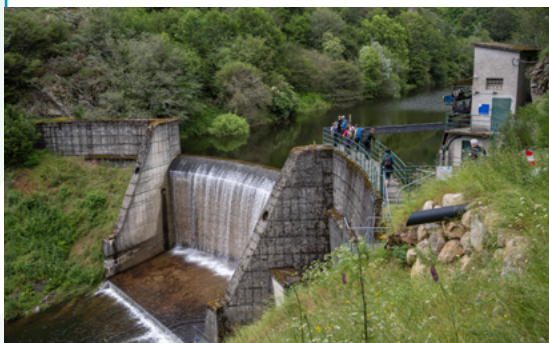
↑ Prise d'eau de la Grange sur la Veyradèyre
